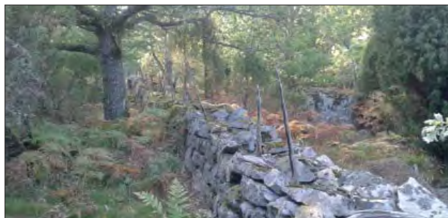
En gedigen stenmur på Jordö. De gamla enekäpparna som ännu sitter nedstuckna i muren vittnar om att ett högre stängsel tillverkades genom att bygga vidare med ett trägärde förstärkt med tornigt ris ovanpå muren.
