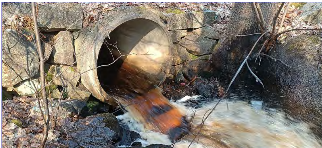
Figur 127: Vandringshinder nummer 1 består av en vägtrumma med fall.
