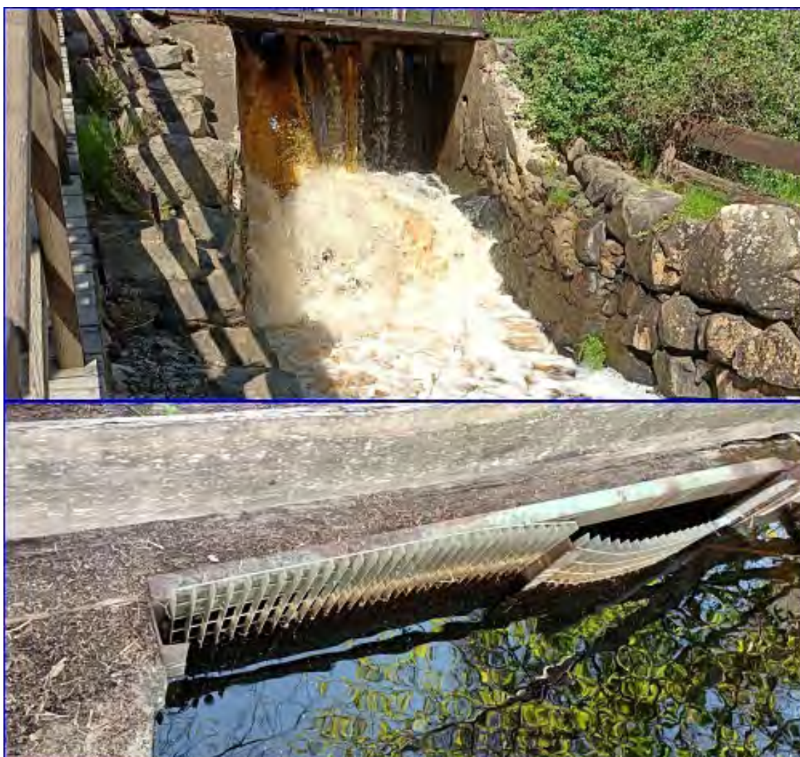
Figur 113: Vandringshinder nummer 15 består av dammluckor med en total fallhöjd på cirka 2,1 meter (övre bilden). Ett slitet galler återfinns vid turbinintaget, detta intag bör förlängas och en nytt rengaller bör installeras för att undvika att fisk ska riskera att hamna i turbiner.
