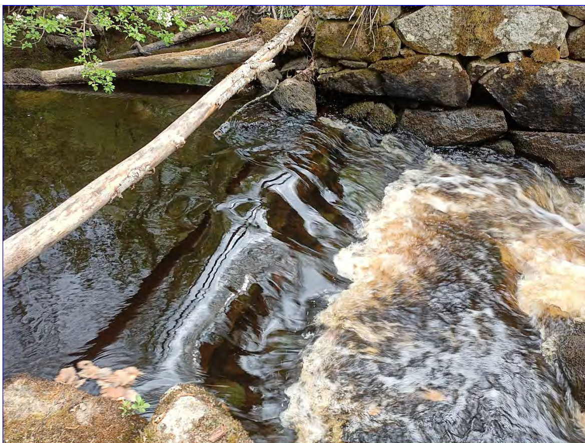
Figur 115: Vandringshinder nummer 16 består av en tröskel efter en kvarnrest. En mindre upptröskling hade åtgärdat vandringshindret.
