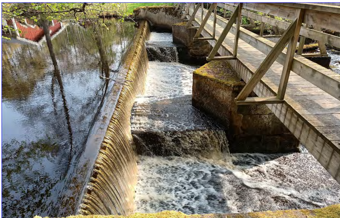
Figur 116: Vandringshinder nummer 17 består av en överfallsdamm utan reglermöjlighet där skibordet är uppfört i tre nivåer. Hindret utgör ett definitivt vandringshinder för både svag och starksimmande arter.
