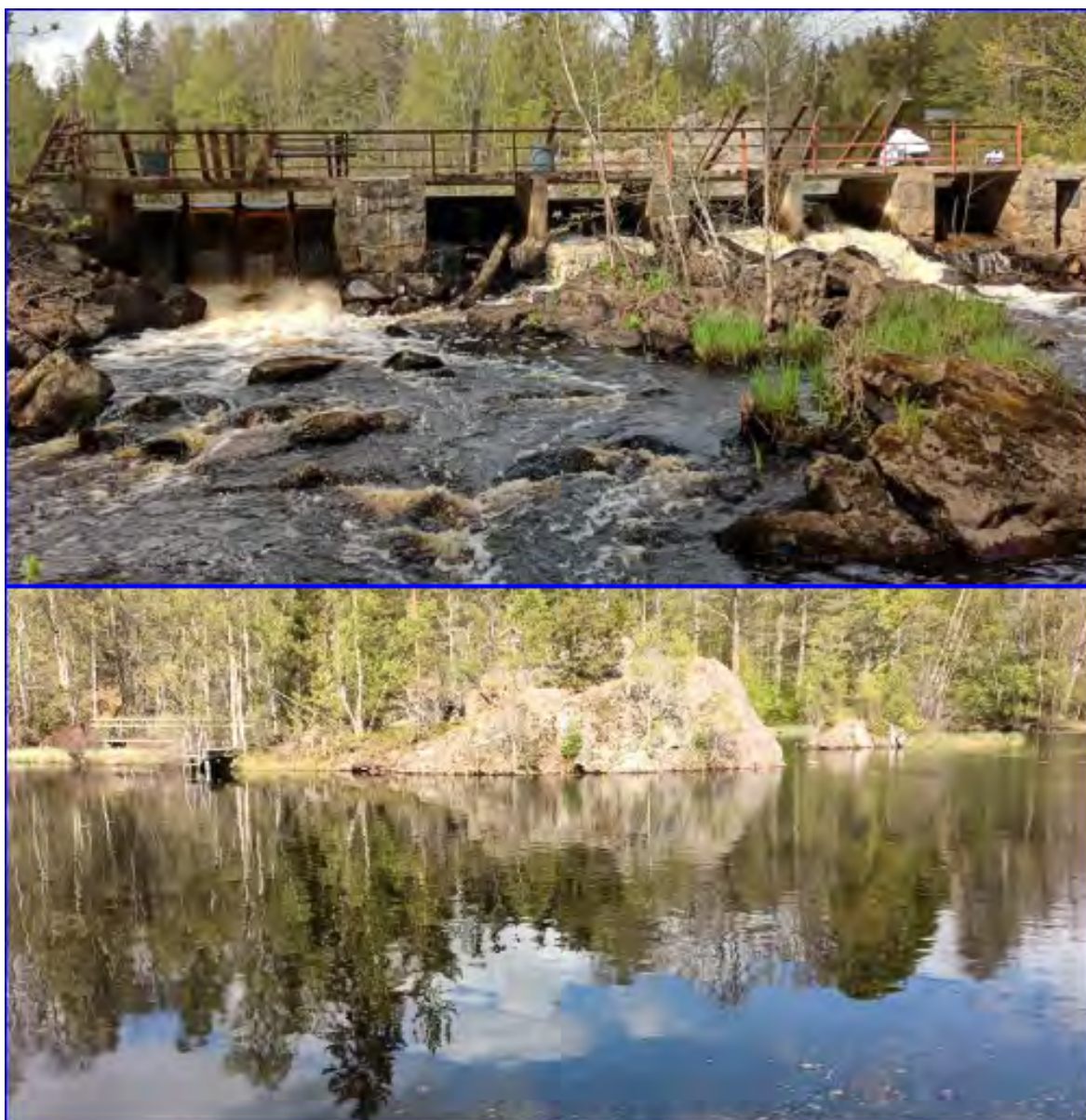
Figur 107: Övre bilden visar vandringshinder nummer 12 som utgörs av en dammvall med flertalet utskov. Undre bilden visar en vy över dammen uppströms.
