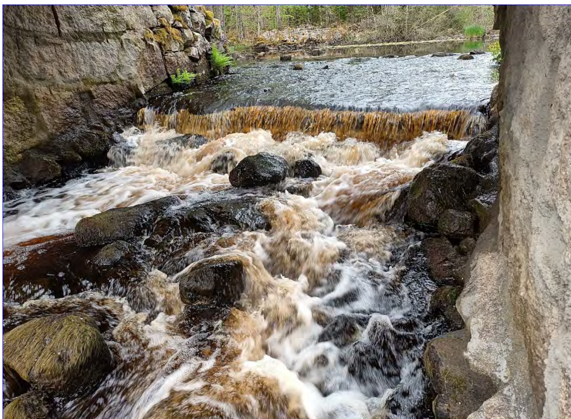
Figur 119: Vandringshinder nummer 18 består av en tröskel efter en utriven kvarndamm som skapar ett fall. Upptäcksling bedöms vara det enklaste alternativet för att förbättra den longitudinella konnektiviteten.
