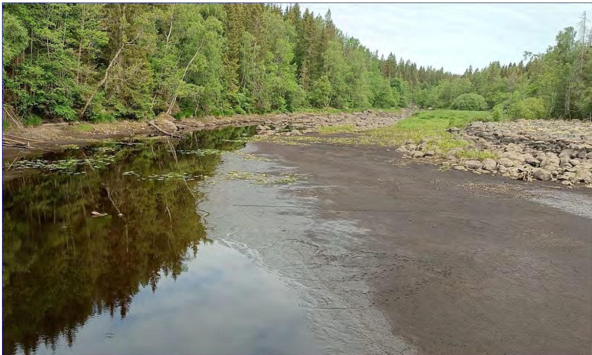
Figur 69: Överdämd strömsträcka och tidigare nyckelbiotop i Bräkneån (sträcka 25 i Bräkneån Lillån-Tiken). Dammen uppvisar en mycket sparsam vattenspegel under sommarhalvåret och stör de fluviala processerna. Notera helt orensade blockrika sträckor som större delar av året är överdämda. Ansamlingen av sediment stör de fluviala processerna och kan leda till ökade erosionsprocesser nedströms.
