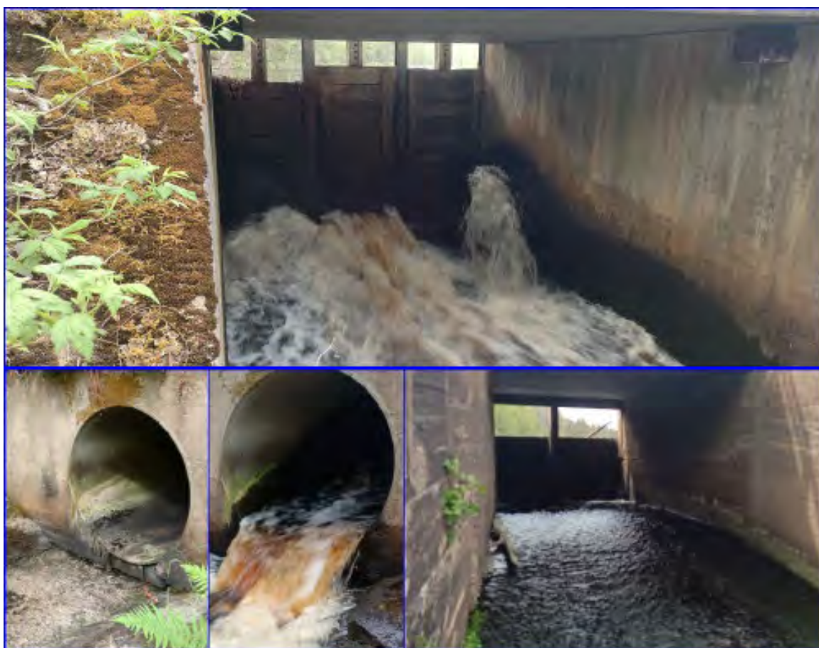
Figur 109: Vandringshinder nummer 13 består av en dammvall kombinerat med en vägpassage med tre utskov i form av en vägtrumma på vattendragets vänstra sida och två spetluckor.
