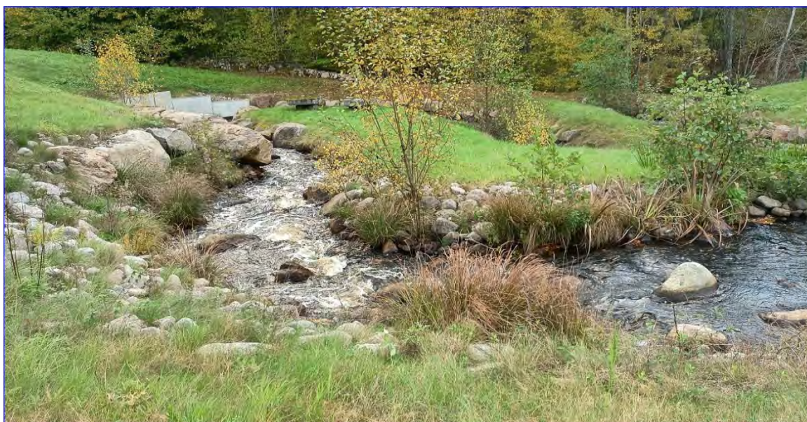
Figur 99: Omlöpet installerades 2016 och tillåter bevisligen passage för både stark- och svagsimmande fiskarter. Fortsatt fiskräkning rekommenderas för att utvärdera effektiviteten.
