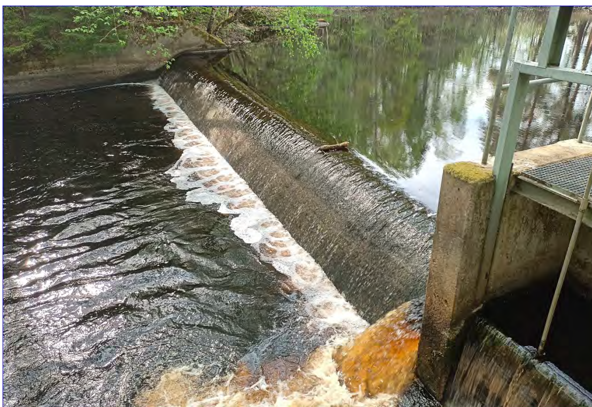
Figur 120: Vandringshinder nummer 19 består av en regleringsanordning för sjön Tiken i form av en gjuten betongvall samt ett reglerbart lågvattenutskov.
