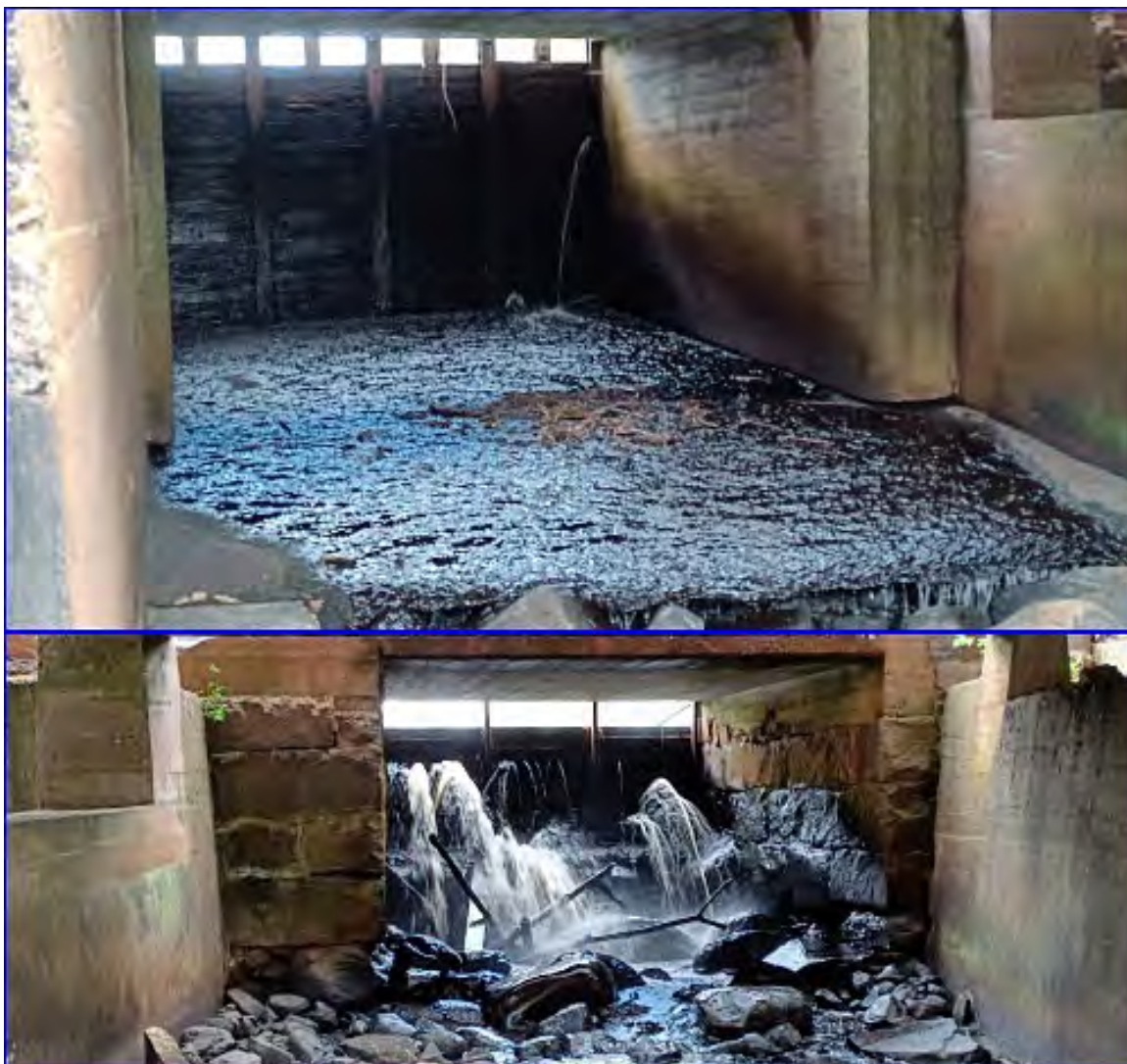
Figur 102: Dammluckor i de två fåror utgör idag definitiva hinder för både stark och svagsimmande fiskarter.
