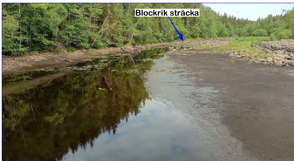
Figur 110: Dammen uppströms hindret håller mycket låga vattennivåer under delar av sommarhalvåret och har dämt över en limnisk nyckelbiotop i form av blockrika sträckor. Bilden är tagen i juni 2022.
