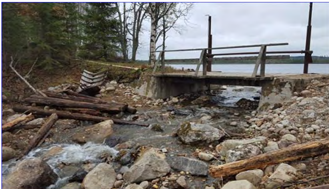
Figur 121: Exempelbild från en likande restaurering där en naturtröskel har återskapats med bibehållen sjönivå. Foto: Länsstyrelsen Västerbotten.
