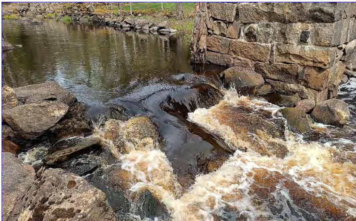
Figur 101: Tröskeln efter utriven kvarndamm hade enkelt kunnat åtgärdas genom en mindre upptröskling och omfördelning av block.
