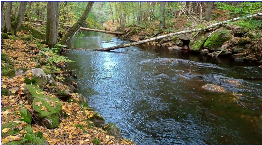
Figur 65: Omgrävd och kraftigt rensad strömsträcka (sträcka 9 i Bräkneån Östersjön-Lillån) med brist på strukturer och en homogen botten, ökad specifik flödeseffekt, avsmalnad och överdjupad fåra. Lekgrus har spolats bort och uppväxthabitat för öring är förlorade. Sträckan avgör basnivån för uppströms belägna TB sträcka som på grund av rensningen idag uppvisar kraftigt sänkta basnivåer och dåliga svämplan.
