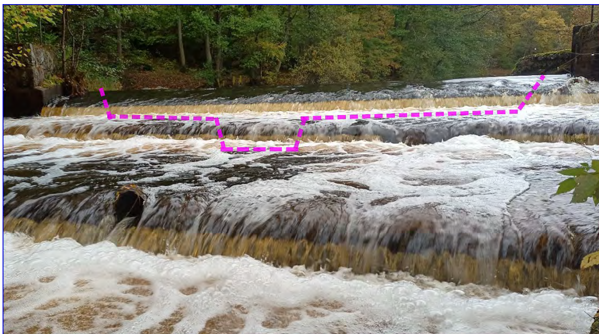
Figur 97: Skissbild över sänkningen av dammen. Nuvarande nivå hade sänkts med cirka 1,6 meter och en mittfåra för koncentration av lågvattenflöden hade utformats. Lila streckade linjer visar en principskiss över tröskelprofilen och sänkningen av skibordet. Sträckningar på bilden är enbart till för att illustrera åtgärderna, inmätningar eller mer ingående projekteringar har inte utförts i det här projektet.
