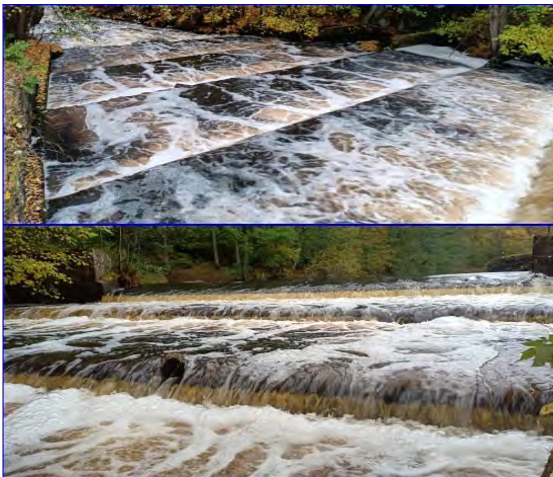
Figur 96: Vandringshinder nummer 6 utgörs av en bassängtrappa där fisken måste hoppa för att kunna passera. Övre bilden visar trappan i strömriktningen, undre bilden visar trappan mot strömriktningen.
