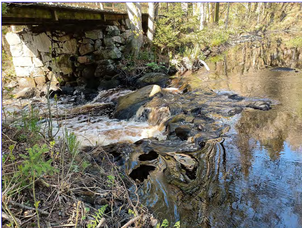
Figur 112: Vandringshinder nummer 14 består av ett fall/tröskel som har skapats efter att en dammvall har rivits ut och kan enkelt åtgärdas genom en inte allt för omfattande upptröskling.
