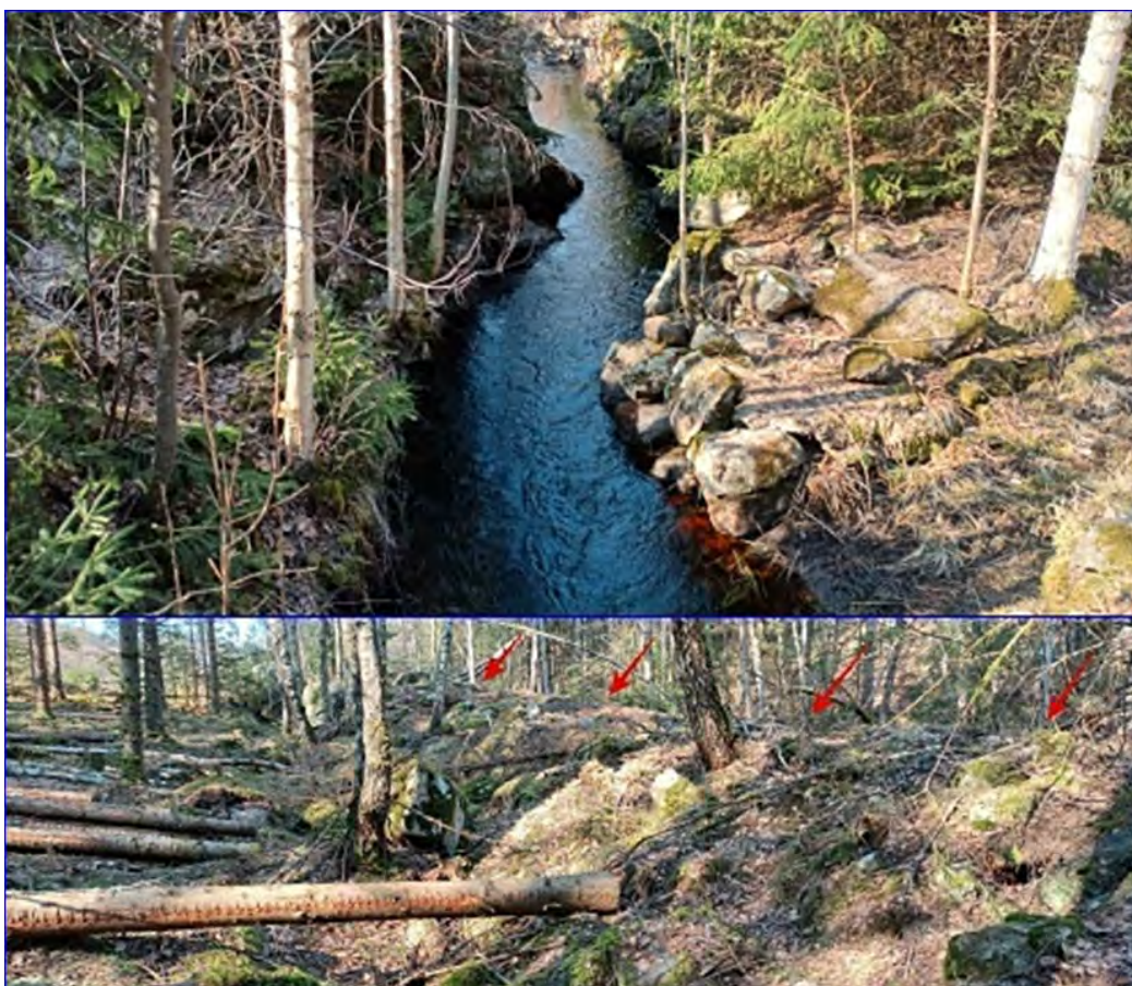
Figur 68: Omgrävd sträcka i Husörenbäcken (sträcka 11) i syfte att skapa produktiv skogsmark. Notera de mycket höga rensvallarna längs vattendragets kanter (röda pilar på nedre bilden). Fåran är idag kanaliserad, har en ökad specifik flödeseffekt, är onaturligt smal, djup och uppvisar en mycket stor brist på heterogenitet och strukturer.
