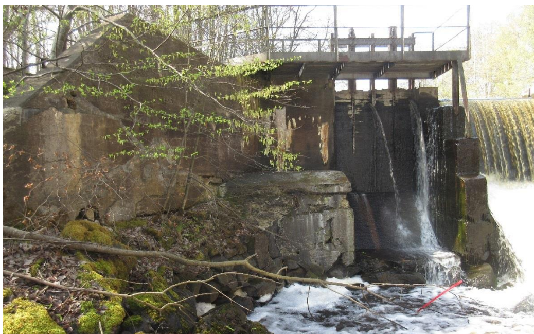
Figur 13 – Flodutskov och pelare, rivs och ersätts med ytterligare spetluckor för ökad avbördningskapacitet. Foto WSP 2019.
