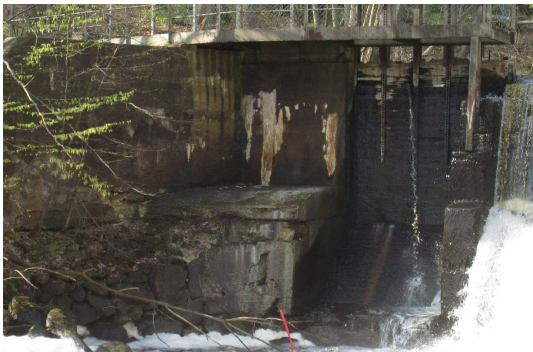
Figur 9 – Nedströmssida av flodutskov med tillhörande dammdel till höger. Foto WSP 2019
