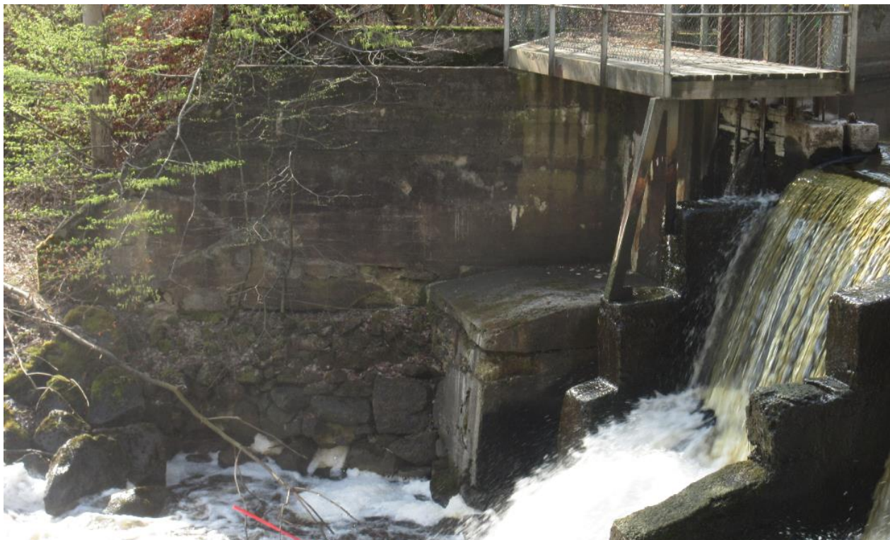
Figur 10 – Vänster pelare av det före detta kraftstationsintaget med underliggande stenläggning. Foto WSP 2019
