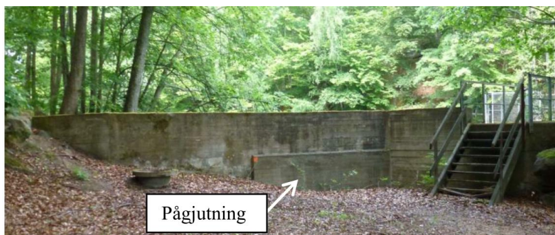
Figur 12 – Pågjutning nedströmssida höger anslutningsmur. Figur hämtad från RAPPORT Fördjupad Damminspektion , WSP 2012-09-18
