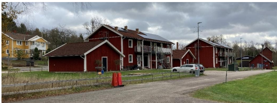
Foto över befintlig bebyggelse belägen öster om det område där planändringen föreslås.
