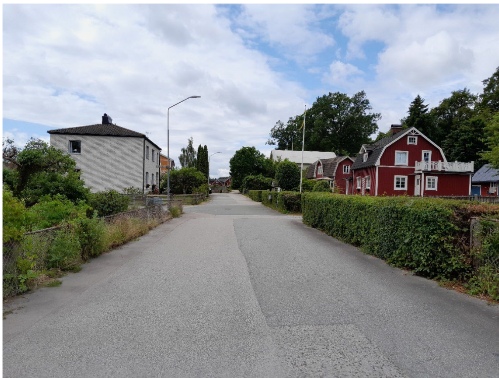
Exempel på blandad sekelskiftesbebyggelse utmed Folkets Husvägen. Foto Planenheten 2025-06-25.
