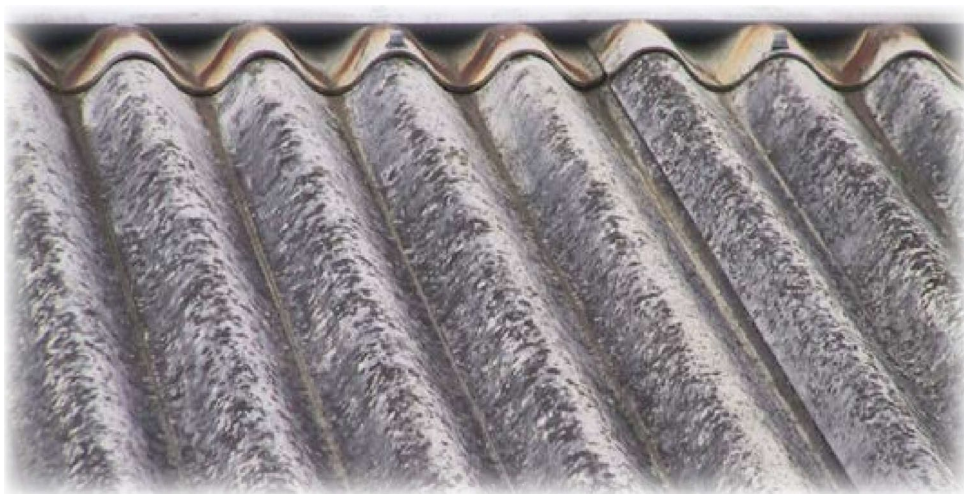
Tak av eternit. Foto: Alsglobal
